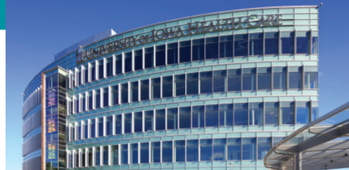
Université de l'Iowa Centre de santé - Iowa City, IA - 6 mm verre claire Velour en position 3 avec un verre énergétique en position 2
